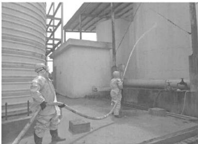
图 3 应急人员对罐体进行喷射降温
