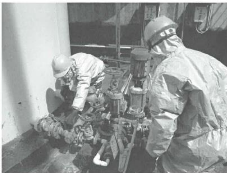
图 5 找出泄漏点并维修
