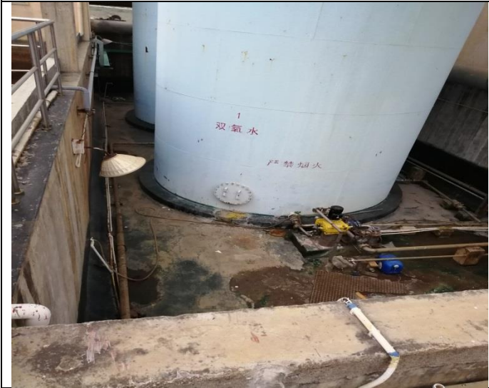
双氧水储罐区围堰
