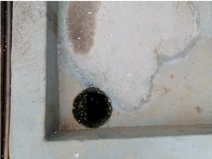
浓硫酸储罐区围堰与导流孔
