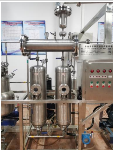
溶剂罐+冷凝器
