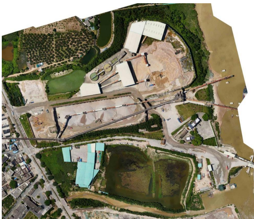
图 1-4 旧矿山水洗砂场地
