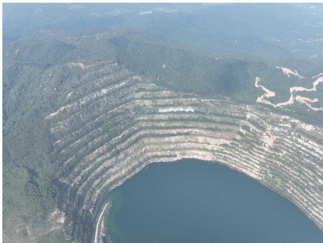
图 2-17 五马同槽山矿区复绿实际情况图
