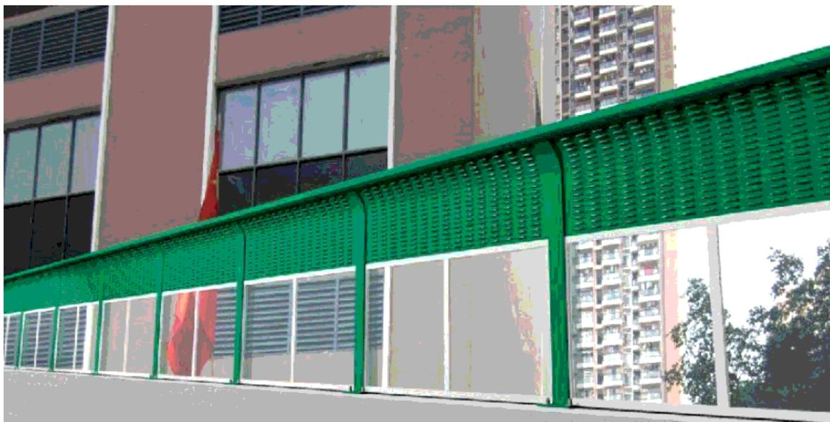
图 6.2-2 直立式声屏障工程实例图
