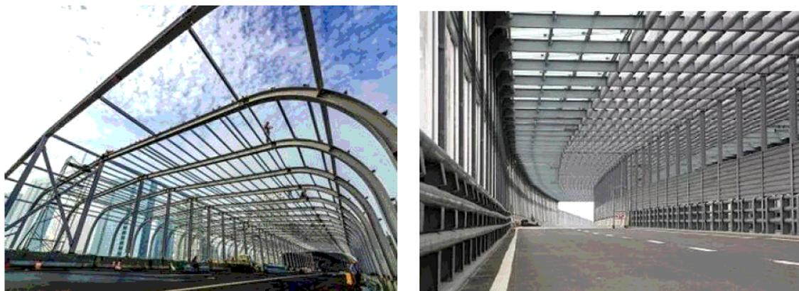
图 6.2-3 全封闭式声屏障工程示例图
