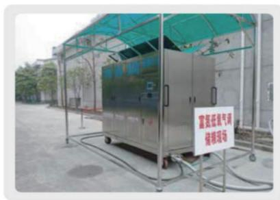
膜分离氮气循环气调储粮现场图
