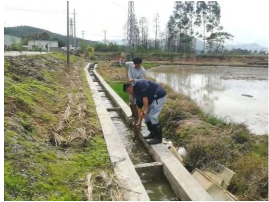
河道灌渠清淤工程
