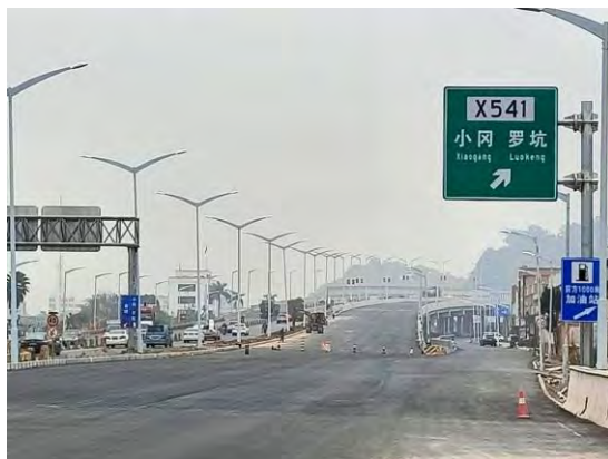
江门大道改造工程
