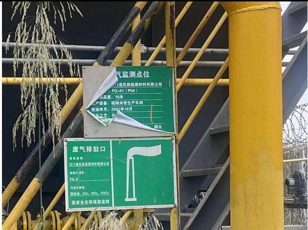
废气排放口近景 (FQ-01)
