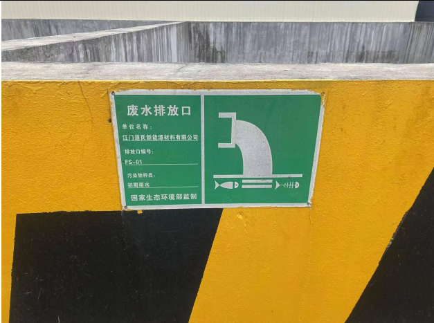
雨水排放口近景（FS-01）
