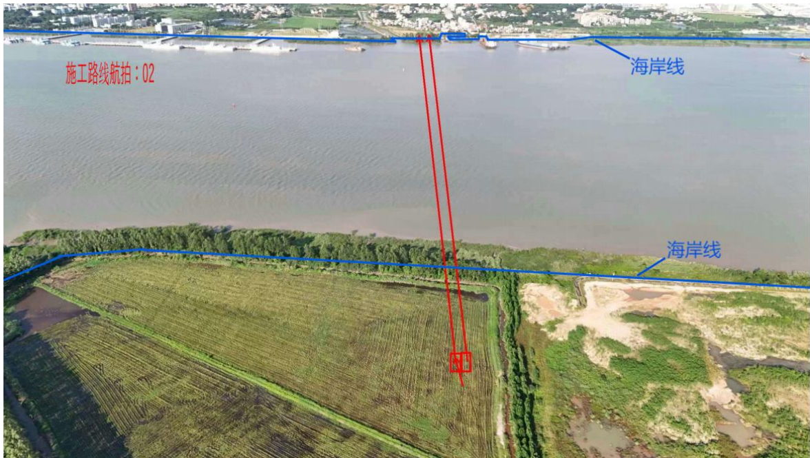
图 5.1.2-3 岸线现状照片
