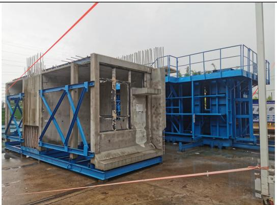
混凝土结构集成模块化建筑模块照片
