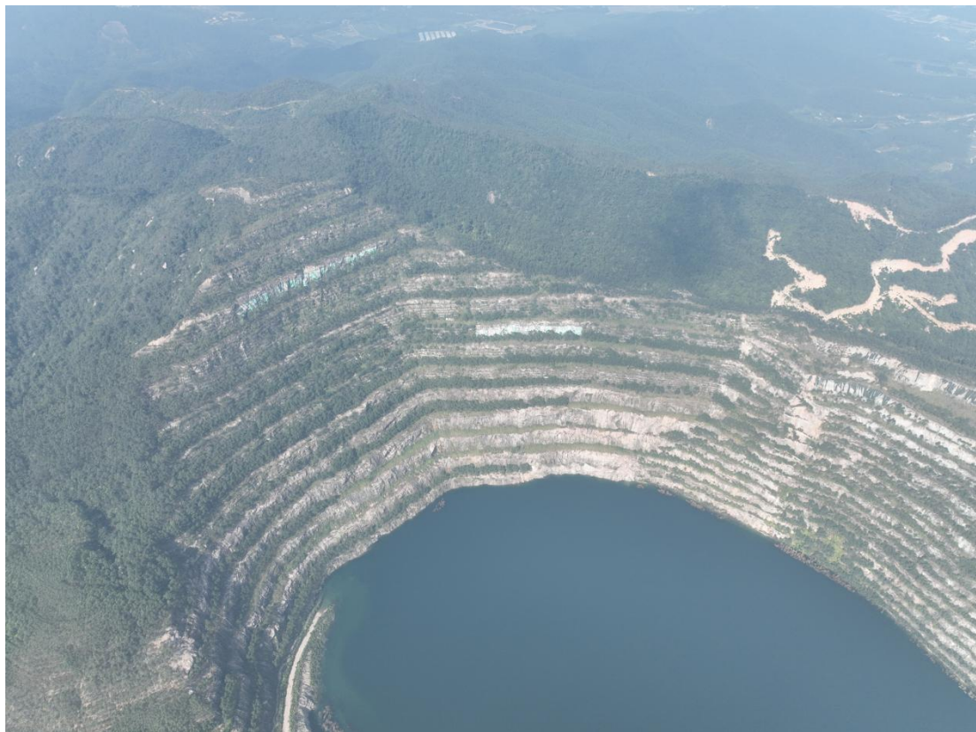
图 2-20 五马同槽山矿区复绿实际情况图
