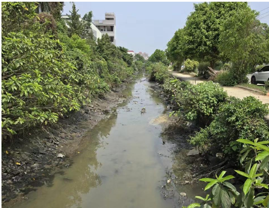
响水河实地照片
