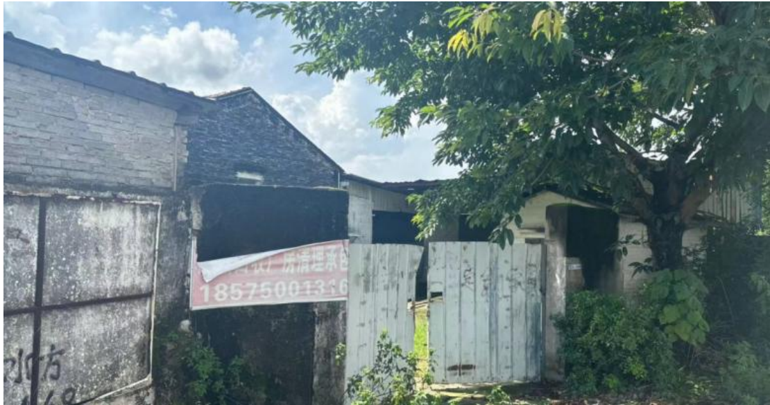
大泽村低效建设用地现状照片
