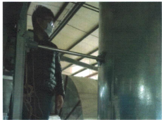
图 5-4 Q2 喷漆工序废气排放口 (E 112°50'51.50", N 23°30'40.07") 有组织废气现场采样照片
