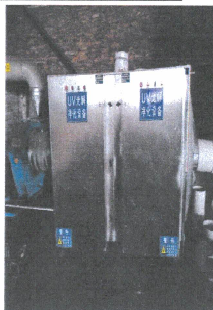
图13 车间废气处理设施: UV 光解
