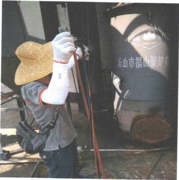
图 1 锅炉废气烟道采样口 (处理前)
