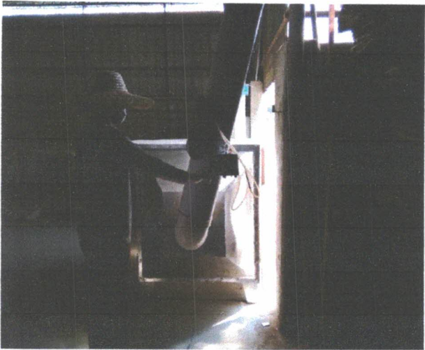
图 3 生产废气排气筒采样口 (处理前)
