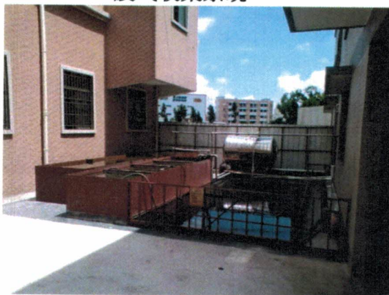
循环冷却水池
