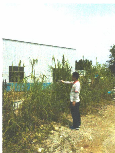
图 12 三期项目南面外 1 米处▲6
