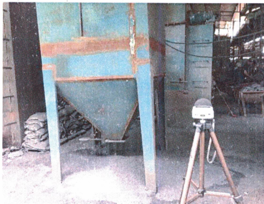
厂界东侧外 1 米处 1#
