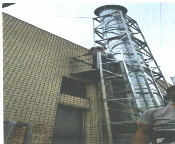
图 5 2#车间废气排气筒采样口 (处理后)
