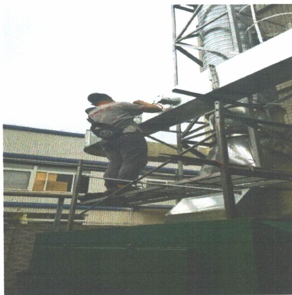
图2 1#车间废气排气筒采样口 (处理前)
