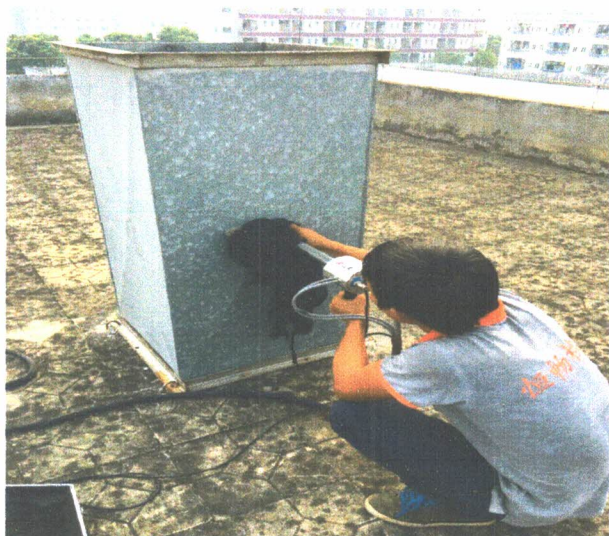
图9 油烟废气排气筒采样口 (处理后)
