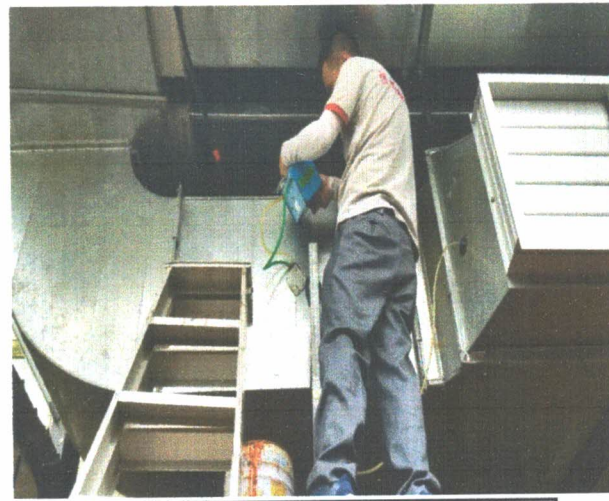
图 6 工艺废气排气筒采样口 (处理前)
